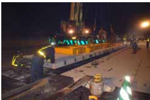
R C プレキャスト舗装版設置状況
