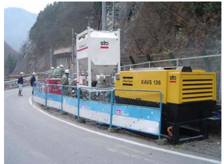
Sto乾式吹付け工法システム
