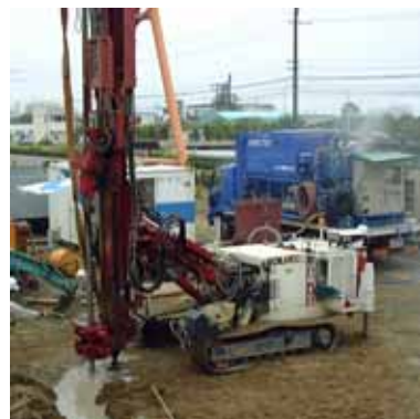
図-2.4.11 試験施工状況
