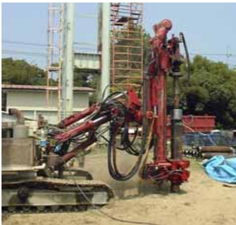
図-2.3.3 二重管削孔・鋼管打設状況
