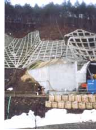
図-2.3.15 新設擁壁基礎施工状況
