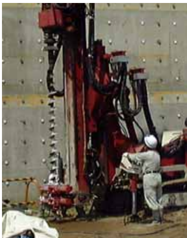
図-2.4.6 オーガー削孔状況
