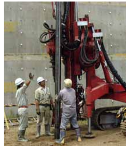
図-2.4.8 鋼管挿入状況
