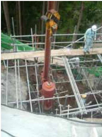
図-2.3.22 急速載荷試験状況 9)
