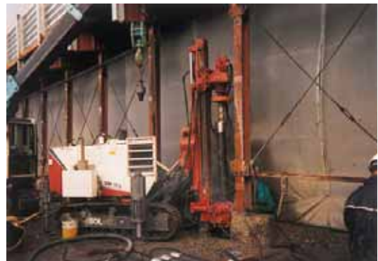
図-2.3.11 スノーシェッド基礎補強状況
