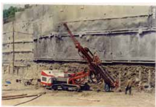
図-2.6.1 削孔機械 SM405
