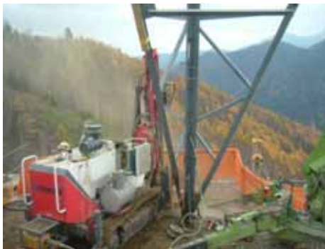
図-2.3.22 基礎補強状況
