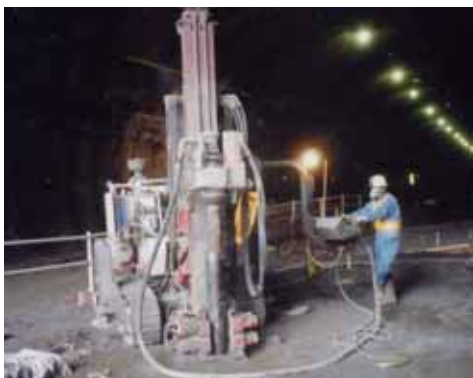
図-2.3.24 脚部補強工施工状況
