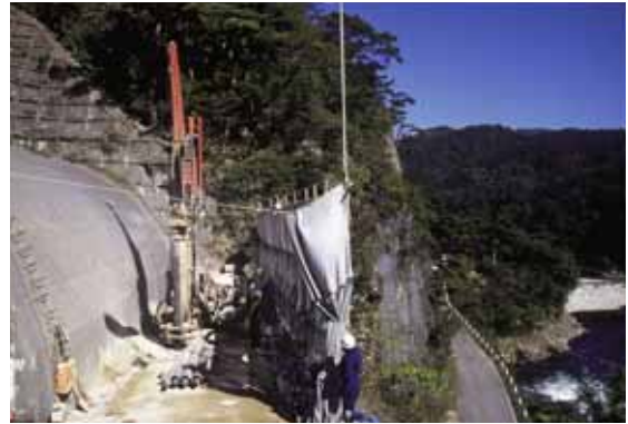
図-2.3.9 L型擁壁基礎杭施工状況
