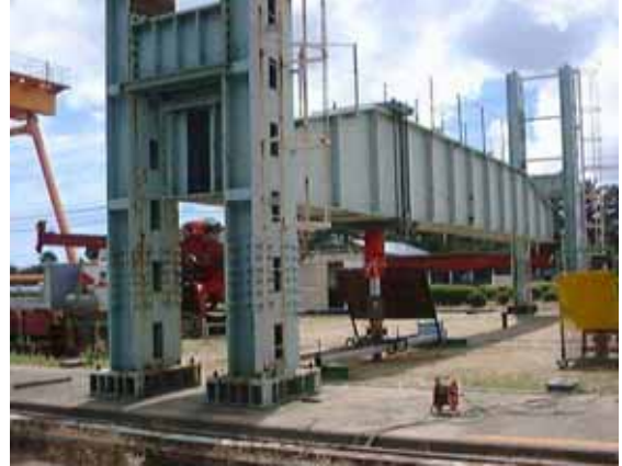
図-2.3.21 鉛直載荷試験状況 8)
