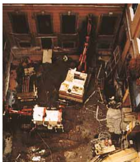
図-1.1.3 海外でのマイクロパイル施工事例 (狭隘地でのマイクロパイル打設)
