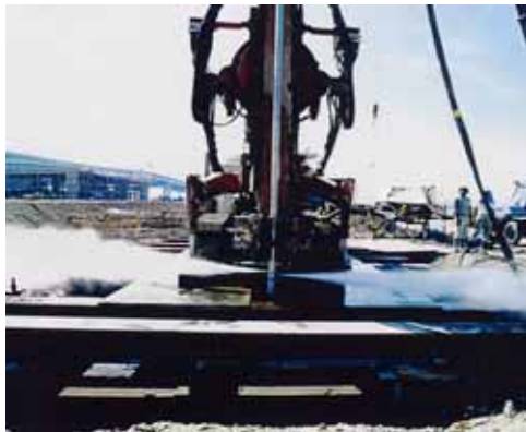
図-2.4.9 試験施工状況
