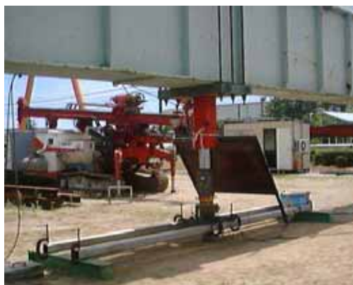
図-2.4.13 鉛直押し込み載荷試験状況
