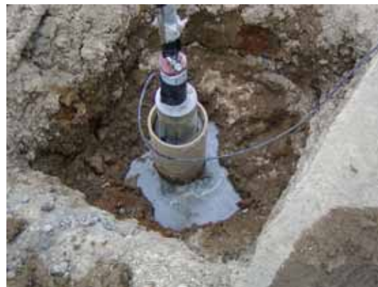
図-2.3.6 グラウトの加圧注入状況
