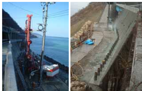
図-2.3.13 既設擁壁の補強状況図
