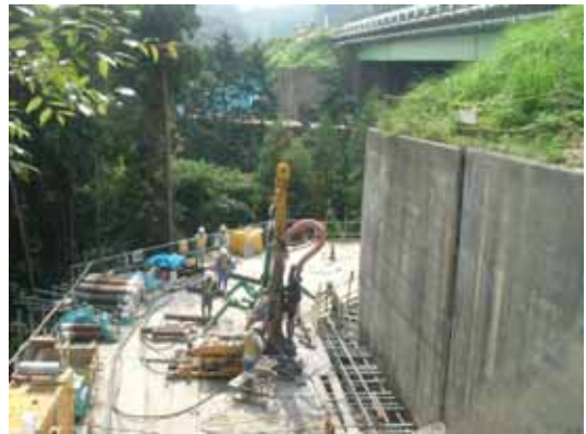
図-2.3.21 組杭抑止杭施工状況
