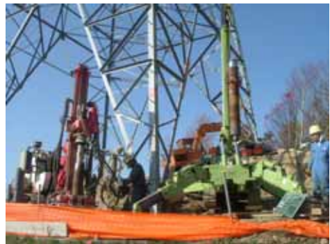
図-2.3.23 基礎補強状況
