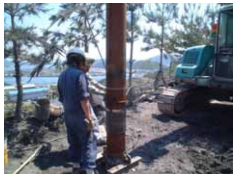
図-2.3.25 抑止杭施工状況
