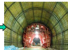
覆工コンクリートの鉄筋組み完了
