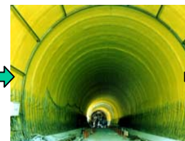
シート展張りの完了
