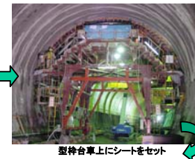
型枠台車上にシートをセット
