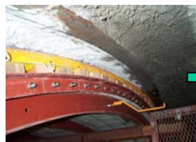
エアバルクによる閉塞と 充填材の流し込み
