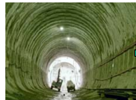
吹付けコンクリートの状況
