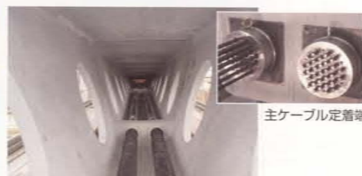
主ケーブルの設置
