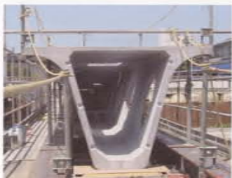
桁の設置状況
