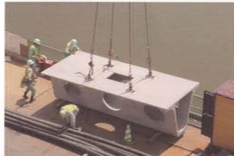
桁の吊り上げ準備
