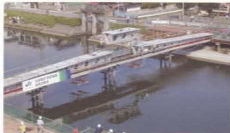
桁の架設
