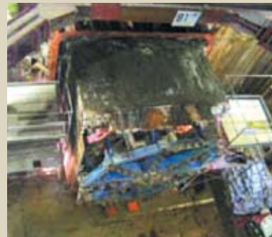
基準トンネル到達状況
