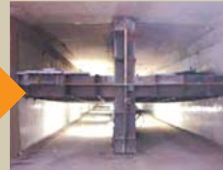
コンクリート打設完了
