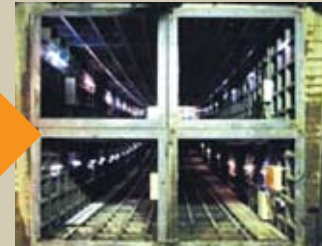
4函体掘削完了
