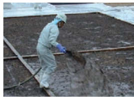
バイオ・セル・ショット工法による吹付植栽
