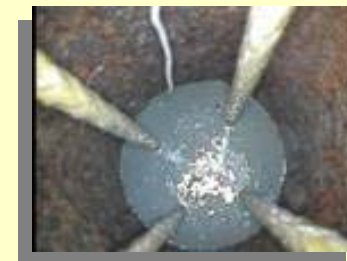
アラミド中空充填工法による地際補強
