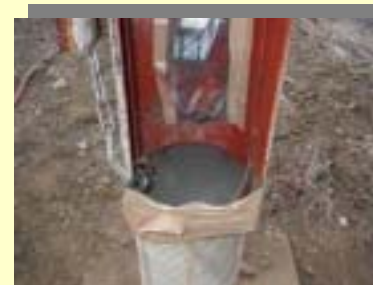
アラミド中空充填工法による地際補強
