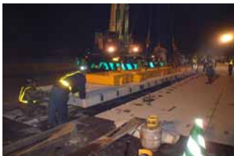
RCプレキャスト舗装版設置状況
