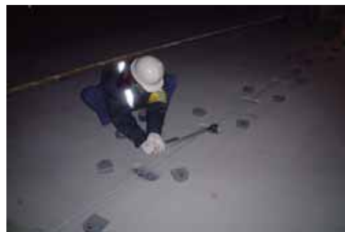
コッター式継手本締付
