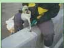
部材間のたて目地に無収縮モルタルを注入する
