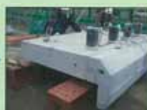
底版と化粧部材を組み立て一体化する
