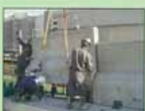
たて壁の鋼管を底版の角型鋼管に挿入設置する
