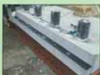
底版と化粧部材を組み立て一体化する
