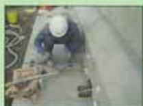
無収縮モルタルを注入し、たて壁と底版を一体化する
