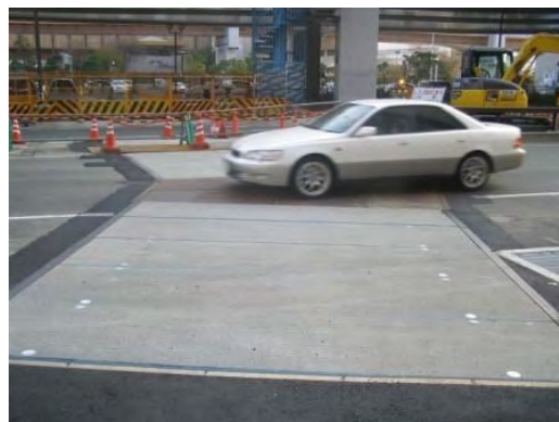
写真2 現場架設状況
