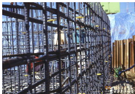
プラスチックスペーサ使用現場
