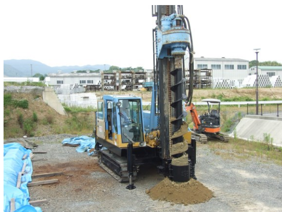
スーパーロックEx掘削状況(完全乾式)
