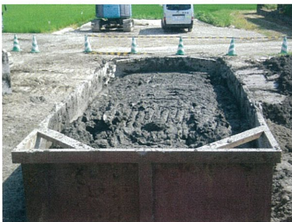
攪拌改良完了
