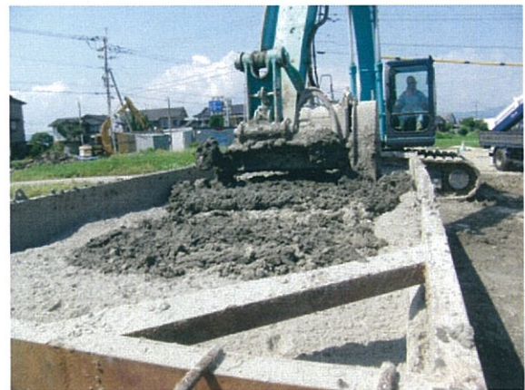
攪拌改良状況
