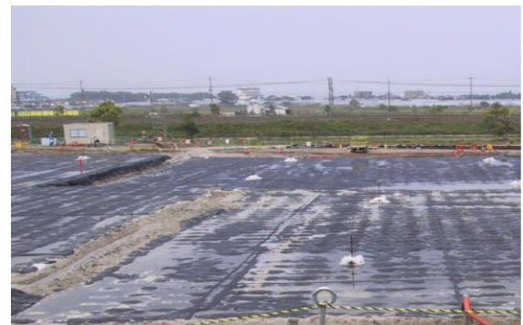
写真-3 施工状況(ポンプ運転中)
