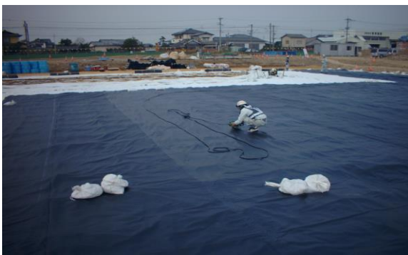
写真-2 施工状況(シート溶着)
