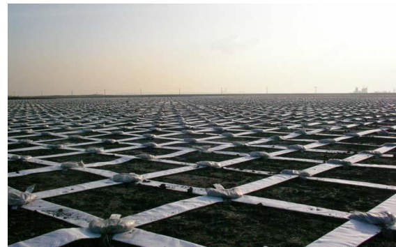
写真-3 施工状況
