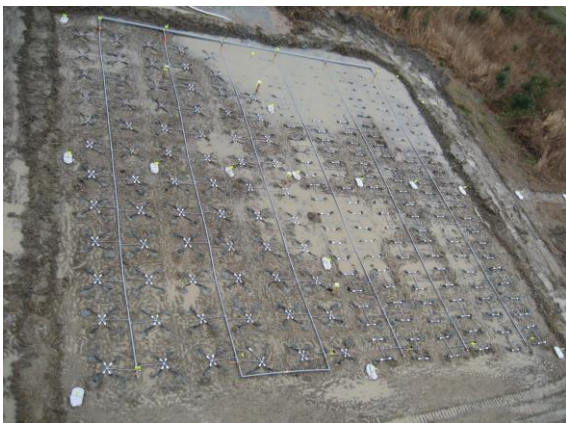
写真-3 施工例(全景)
