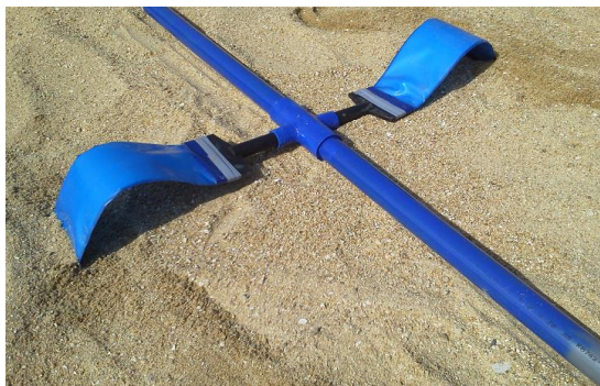
写真-1 ドレーンと集水管接続例
