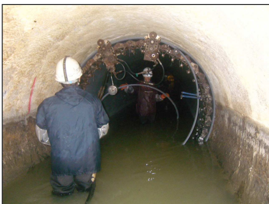
[円形渠(下水道管渠)の更生]
