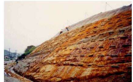
写真-4 ミラクルボードの設置状況
