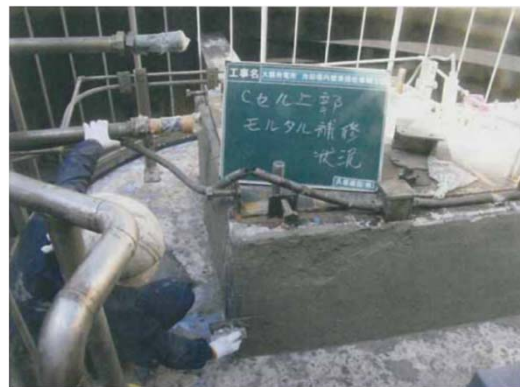
写真 地熱発電所(冷却塔)コンクリート酸性劣化補修
