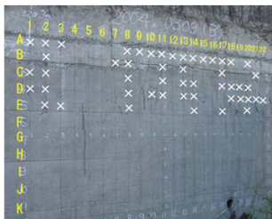
実構造物の打音検査 (X印は異常と判断された箇所)
