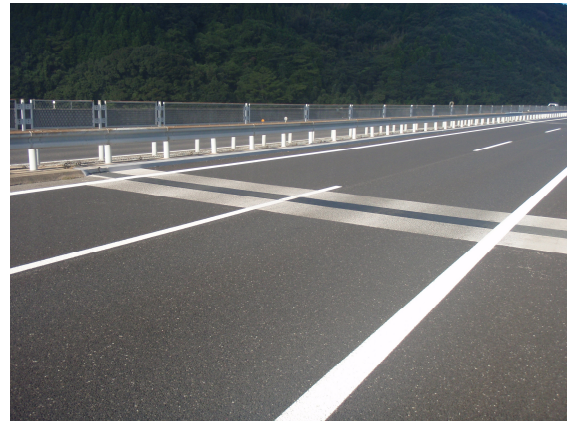
長崎自動車道 撰分高架橋
