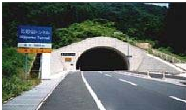
写真-4 自動車道のコンクリート舗装路
