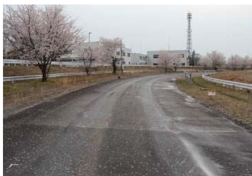
写真-2 250万輪 工区-1
