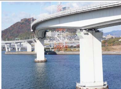
海上部 高橋脚全景
