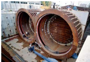
沈埋函端部 沈埋函/シールドマシン接合
