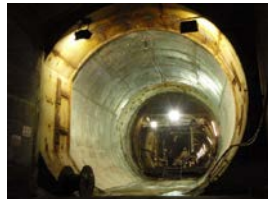
接合完了・一体化
