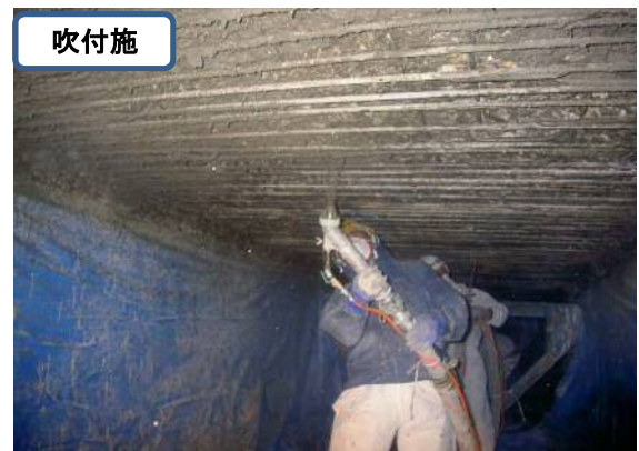
N-SSI工法施工状況
