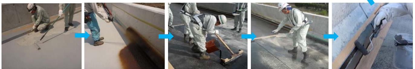
プライマー塗布
