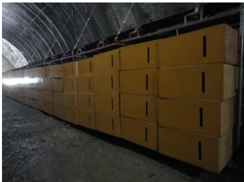
吸音ボックス設置状況
