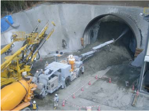
実施工の状況
