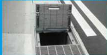
溝幅500mm 鳥取県米子市 2009年2月施工
