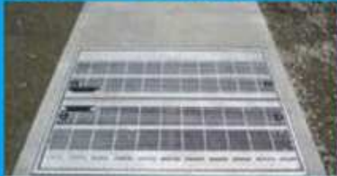
溝幅1000mm 香川県高松市 2010年4月施工
