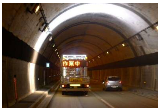
① トンネル覆工撮影
