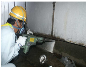
アンカー削孔
