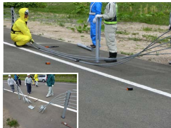
写真-2 開放区間の設置状況
