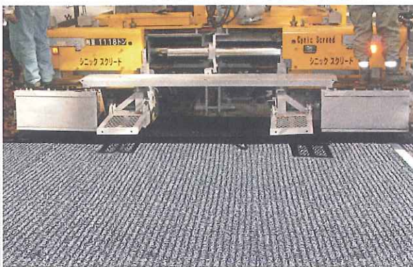
シニックスクリードによる敷均し状況
