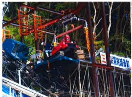
荷台をステージに合わせて角度調整。建機の自走での積み下ろしが可能に。
