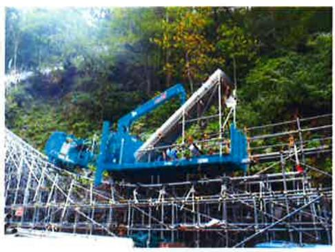
傾斜に合わせてクレーンの角度を調整。アウトリガーの張り出し接地と操作性を確保。
