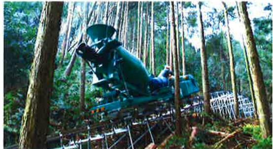
ミキサーにより生コン品質を確保。傾斜地でもミキサーがダンプすることで漏えいを防止。
