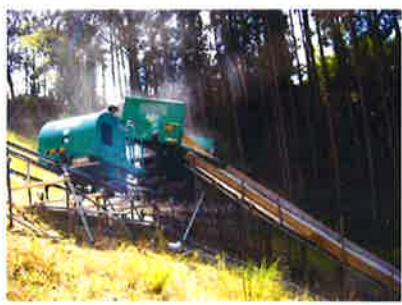
ダンプによる土砂の一括排出。土砂運搬の作業効率が向上。
