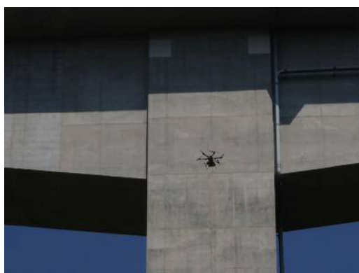
橋脚点検作業状況
