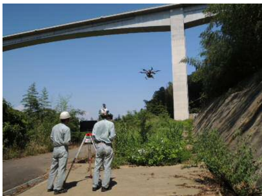
橋梁点検作業状況全景
