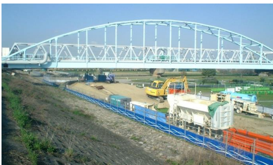
写真-4 橋梁下における施工
