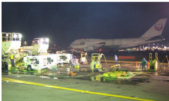
写真-2 空港誘導路における施工
