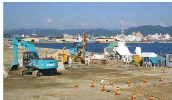
写真-3 護岸背面部の施工
