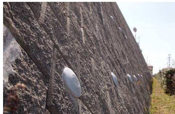
突起物をつくらず、擁壁を補強
