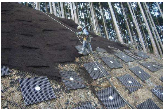
受圧板との併用で、法面を全面緑化
