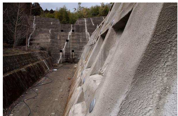
水路内に突起物をつくらず、護岸を補強
