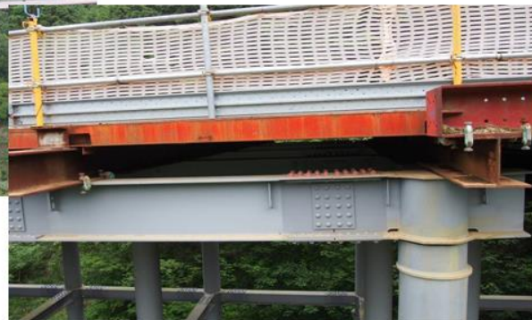
橋の裏の確認
