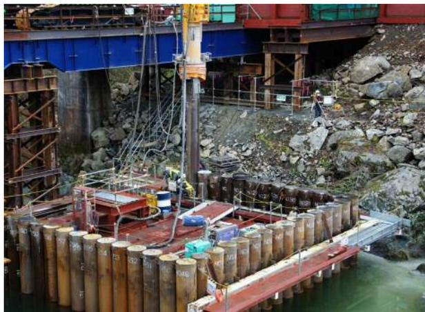
ダウンザホールハンマ拡張ビット掘削と鋼管矢板建込の同時進行
