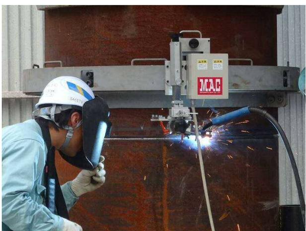
専用鋼管溶接ロボット「ぐるりっ！」による確実な現場溶接
