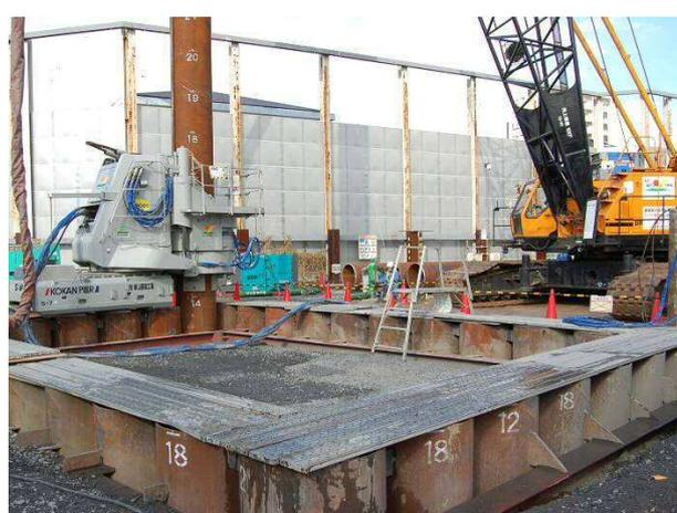
都市型施工に対応した低騒音・低振動の圧入施工
