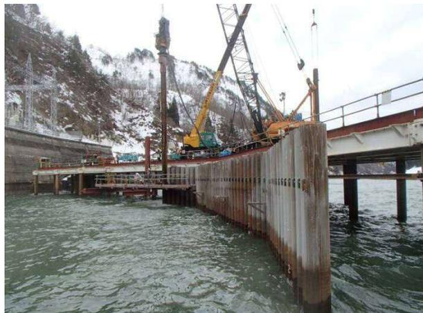
栈橋(LIBRA橋)上からのダム下流の潜り堤(溺堤)補強工事
