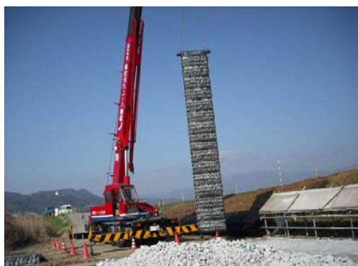
吊上げ状況 《片吊り》
