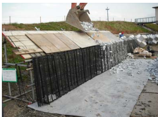
中詰材充填用架台、中詰材充填
