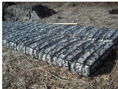
中詰材充填後
