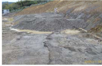
応急対策の押え盛土
