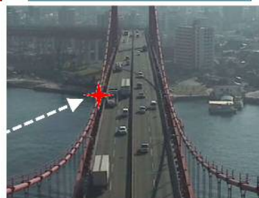
2010/01/19 AM10時26分 の一般車両通行状況
