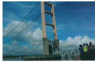
インドネシア クタイ・カルタネラ吊橋落橋事故
