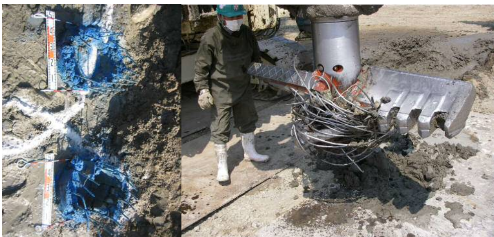
写真—2 既製コンクリート杭破碎・改良同時施工状況(PHC杭; \phi 450mm)
