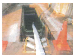
真地下水管推進工事 赤松町 福岡県
