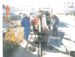
下水道(圧送)管推進工事 千歳市 千歳市
