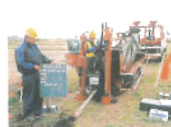
真地下水管推進工事 瀬野町 徳島県
