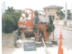
通信ケーブル推進工事 柳川町 福岡市
