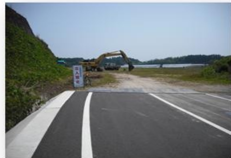
使用例: 工事現場入り口養生
