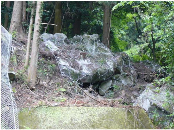
(施工現場: 福岡市早良区曲漕)
