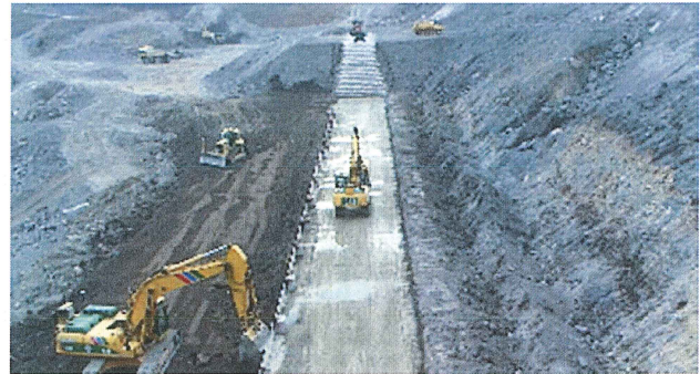
施工盛土および打設前清掃状況
