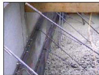
④コンクリート打ち込み
