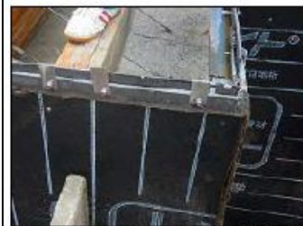
③目地材を予め型枠に固定しておく
