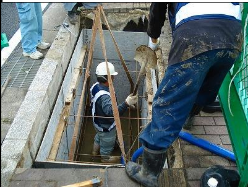
狭隘な箇所の大型標識施工状況
