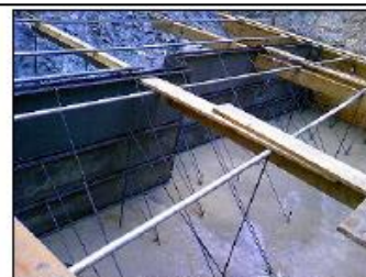
②サポート筋で型枠の固定
