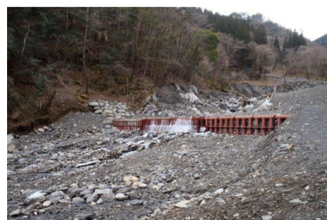
施工1年後の状況
