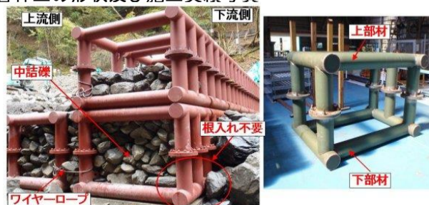
鋼管枠工の形状
