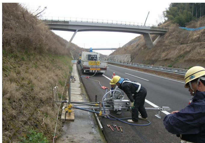
高速道路法面での施工状況
